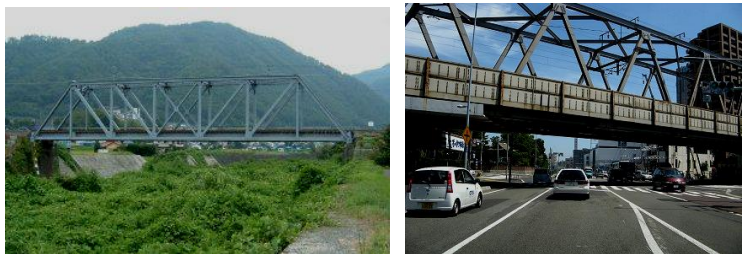
図 2 代表的なトラス橋（ワーレントラス）
