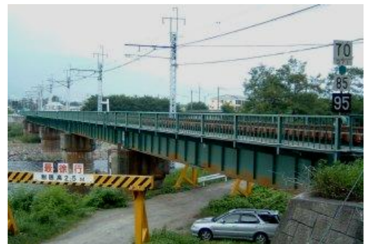
図 1 桁橋（ガーター橋）
